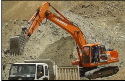
Fig. 8. Retroexcavadora Daewoo Solar.
