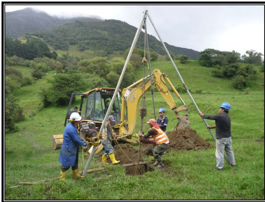
PRESENCIA DE NIVEL FREÁTICO A 3,4 M EN LA CALICATA Nº 12 - FOTO Nº 26
