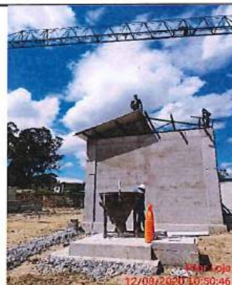
COLOCACIÓN DE CUBIERTA EN EDIFICIO DE DESHIDRATACIÓN
