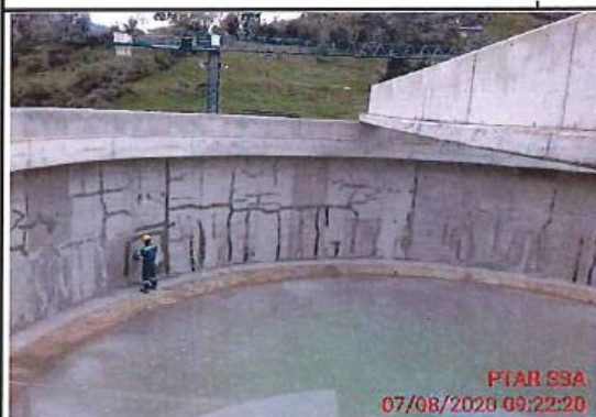
IMPERMEABILIZACIÓN DE PAREDES INTERIORES ESPESADORES DE FANGOS
