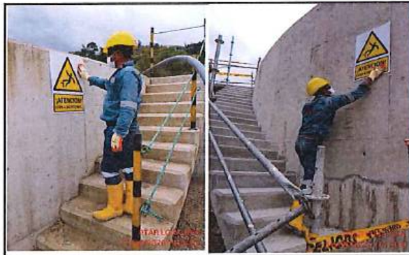
COLOCACIÓN DE SEÑALÉTICA PROVISIONAL DE ADVERTENCIA EN PRETRATAMIENTO Y ESPESADORES DE FANGOS PARA EVITAR CAÍDA A DIFERENTE NIVEL
