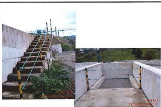
COLOCACIÓN DE BARANDILLAS PROVISIONALES EN PRETRATAMIENTO, DECANTADORES PRIMARIOS, ESPESADORES DE FANGOS
