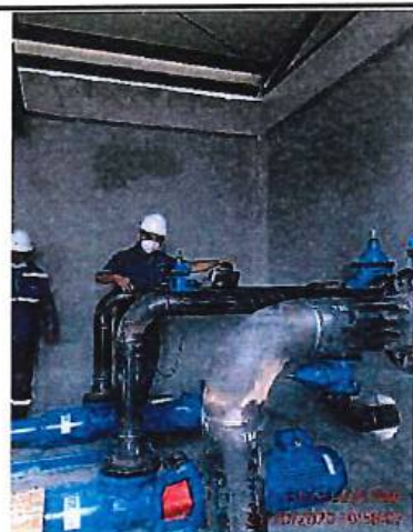
Montaje de bombas en edificios de bombeo de primarios y secundarios
