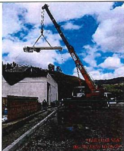
Izaje y posicionamiento de Puente Grúa en Cloración
