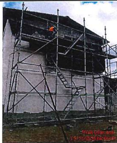
Enlucido de paredes en edificio de cloración
