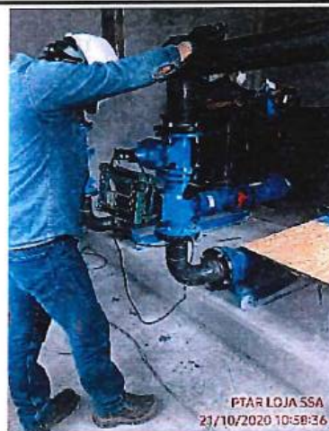
Montaje de bombas en edificios de bombeo de primarios y secundarios
