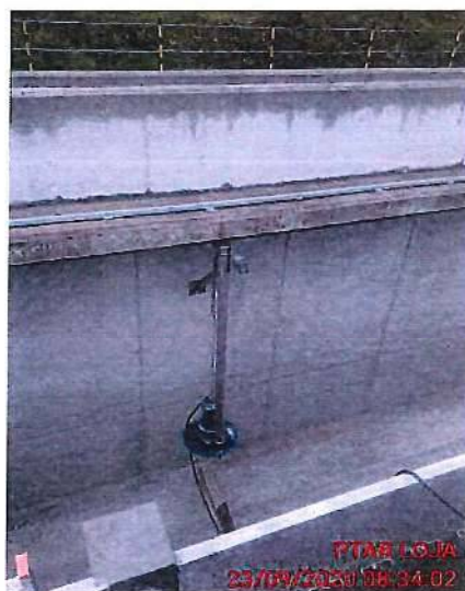
EQUIPO INSTALADO EN OBRA: Electroturbina de aireación en desarenadores.
