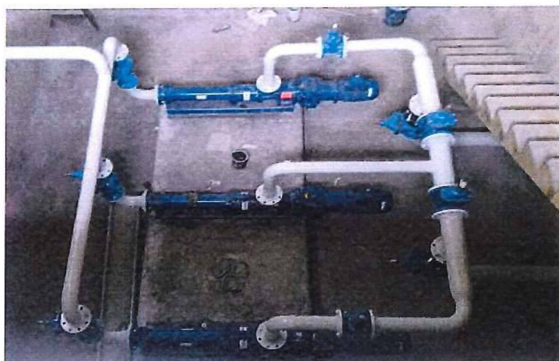
EQUIPO INSTALADO EN OBRA: Bombas de impulsión de fangos biológicos a espesadores
