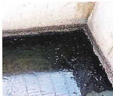
Vertido aceite acumulado canales de ingreso a desbaste grueso
