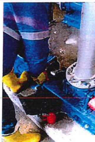
MANTENIMIENTO: LUBRICACIÓN ROTOR Y ESTATOR BOMBAS DE TORNILLO
