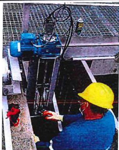
MANTENIMIENTO DE RASQUETAS PUENTES DESARENADORES
