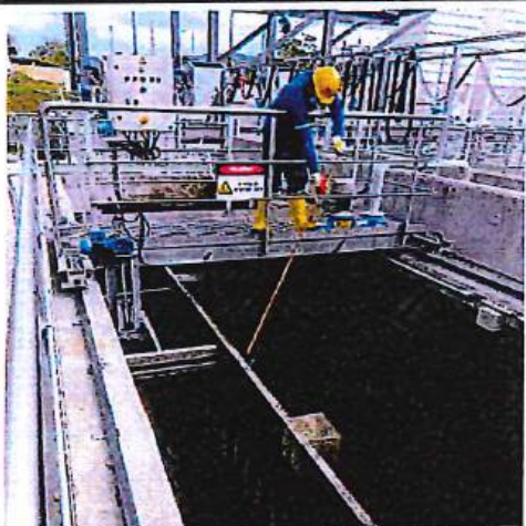
LIMPIEZA DE ELECTROTURBINAS Y PUENTES DESARENADORES
