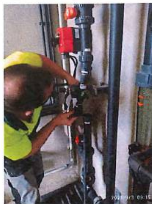
Revisión válvula de dosificación de cloro
