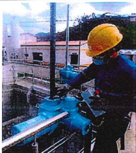
MANTENIMIENTO COMPUERTAS
