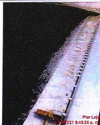
LIMPIEZA DE DISTRIBUIDORES ROTATIVOS
