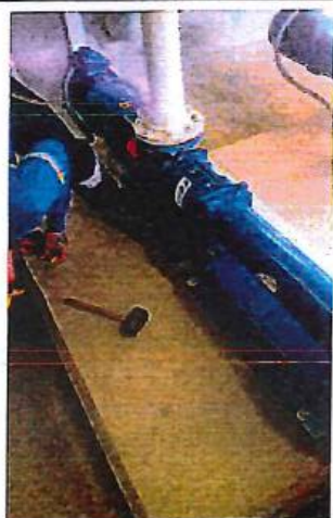
MANTENIMIENTO A BOMBAS DE TORNILLO
