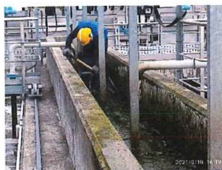
Limpieza de los canales de succión de arenas.
