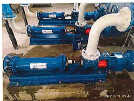
Engrasado bombas de alimentación de fangos a deshidratación
