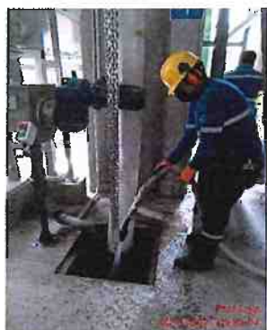
LIMPIEZA DE POZOS EN EL EDIFICIO DE DESHIDRATACIÓN
