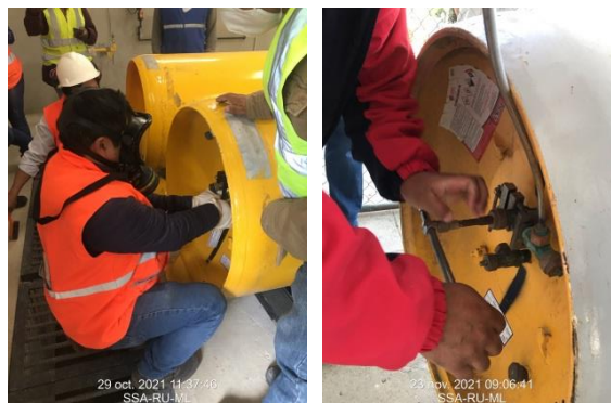
Imagen 02 – 03 Capacitación – cambio de accesorios de tanque cloro gas - actuadores
