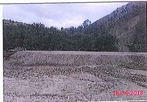
Conformación de plataforma producto de excavación
