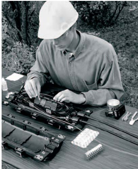
Fig. 10. Procedimiento de armado de manga de empalme lineal.
