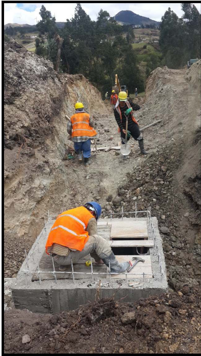
Fotografía Nro. 1.-Pozos pluviales en calle 12.
