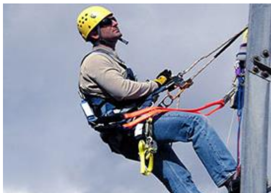
Imagen 10: Uso de Epp`s para trabajos en altura.
